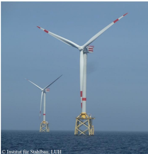
Abbildung 1: Offshore Windenergieanlage mit Jacketgründungsstruktur aus dem Windpark alha ventus
