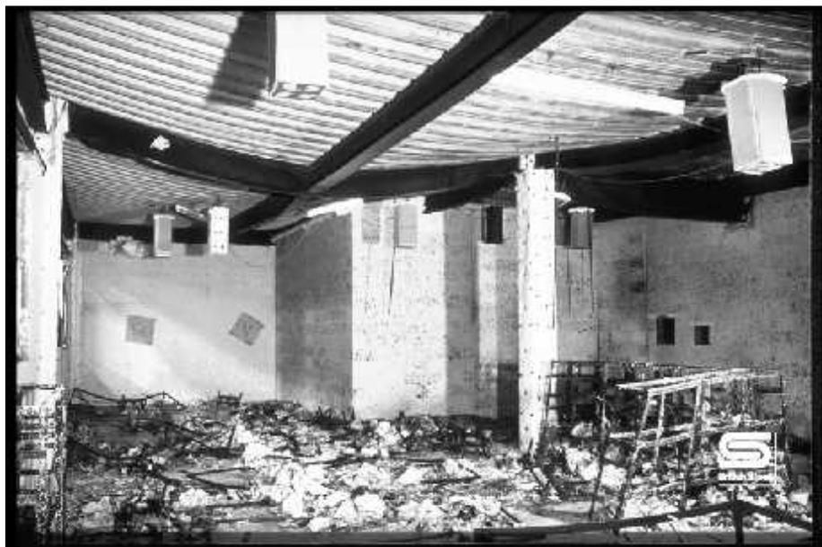
*Bild 5 Brandabschnitt nach dem Brand (Foto: British Steel)*
