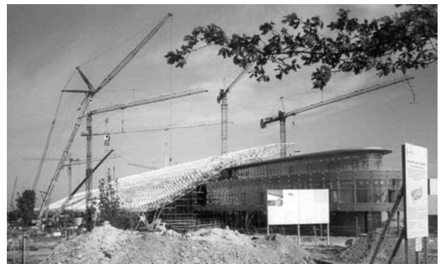
Bild 1-2 Verwaltungsgebäude der dvg, Hannover ungeschütztes Stahlmodul-Dachtragwerk
