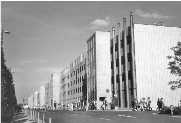
Bild 1-1 Parkhaus Nord, Hannover Messe ungeschützte Stahlstützen und Verbundträger
