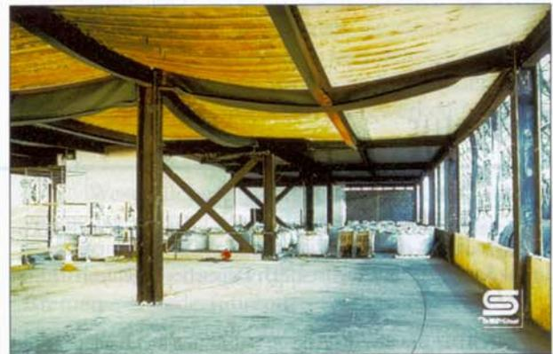
Abb. 7: Brandabschnitt nach dem Brand (Foto: British Steel)
