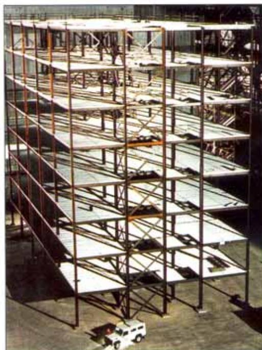
**Abbildung 1.1: Cardington Versuchsgebäude vor der Betonage der Decken [1]**
