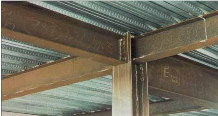
**Abbildung 1.2: Ungeschützte Stahlkonstruktion [1]**
