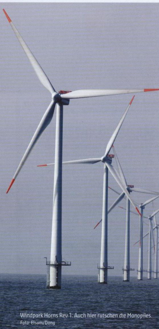
weise sind die Stahlflächen nicht mit Farbbeschichtungen versehen. Bei großen und schweren Offshore-Konstruktionen im Öl- und Gasbereich sind diese Verbindungen bewährt. Bei den Windturbinen rutscht nun in dieser Verbindung das äußere Verbindungsrohr nach unten.
