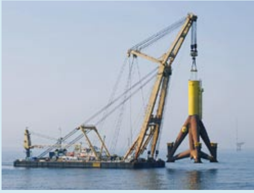
Abbildung 5: Gründungskonzepte für OWEA in Stahlbauweise (Quellen: DOTI, BARD)
