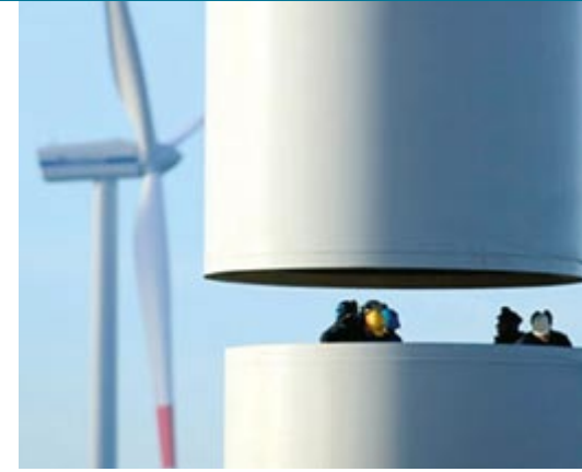
Abbildung 4: Stahlturmmontage (Foto: Vestas, Europe)
