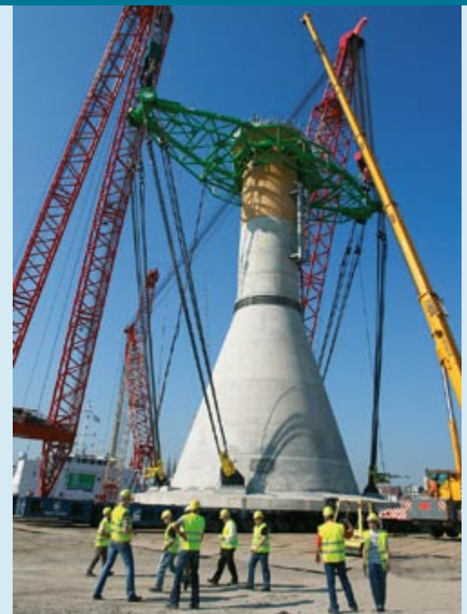
Abbildung 7: Schwergewichtsgründungen für den Offshore-Windpark „Thornton Bank“ (Quelle: C-Power)
