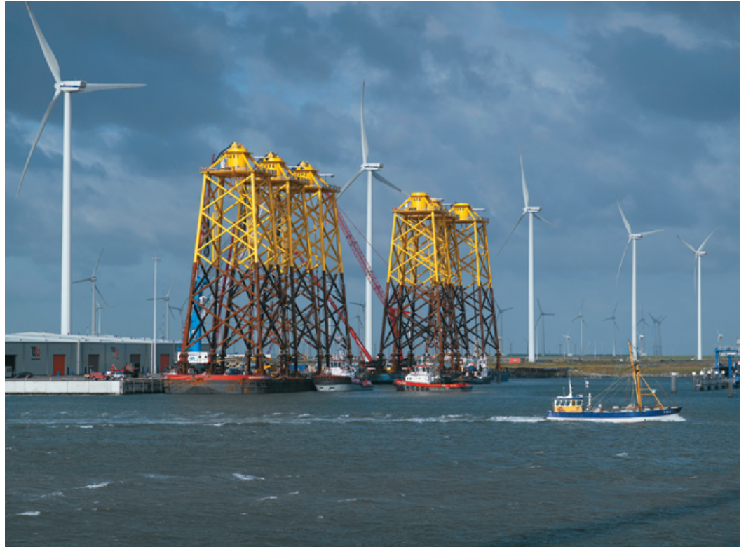
Abbildung 4 Jackets als Unterstruktur für Alpha Ventus Quelle: Matthias Ibeler aus [AV]
